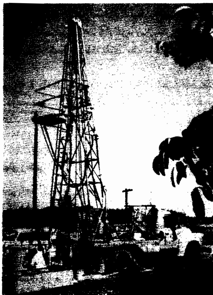
شکل ۵-۶: حفاری روتاری برای بررسی وضعیت خاک
